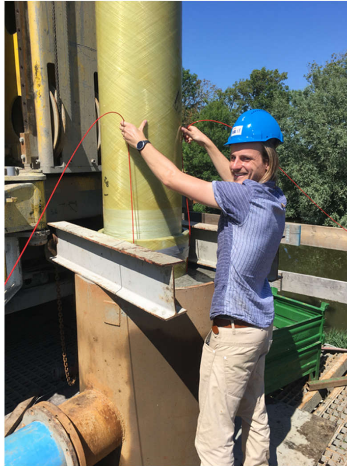
Composiet put, met glasvezel DTS kabel
