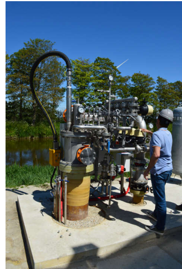
HT-bron met peilbuizen
